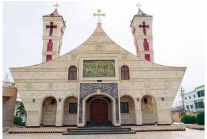
Die vom IS zerstörte syrisch-katholische Kathedrale in Karakosch wurde wieder aufgebaut.
